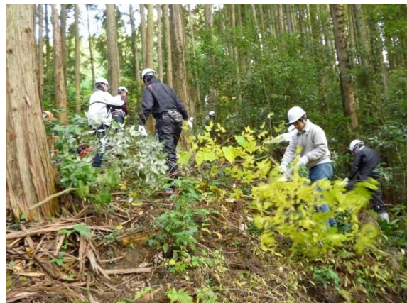
足場の悪い斜面も刈り払います
