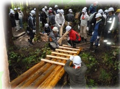
新しい橋をかけ釘うち作業
