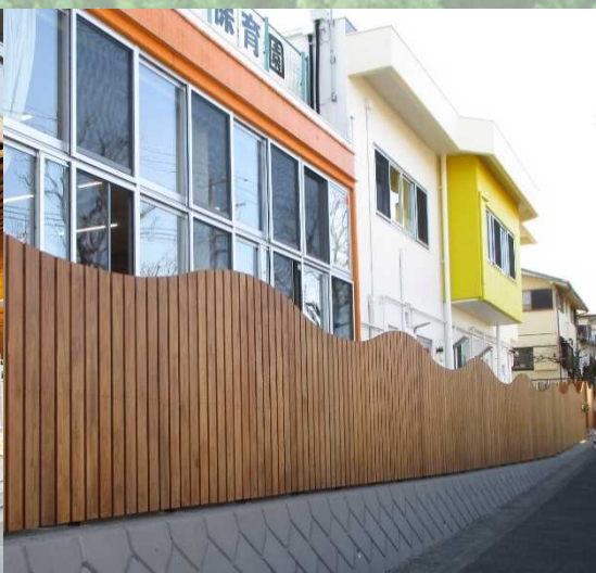
町田南保育園(町田市) 令和4年 2月竣工
