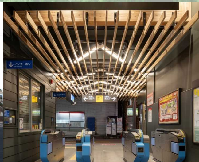
池上線長原駅(大田区) 令和3年12月竣工
