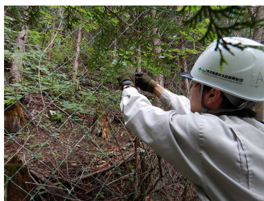
シカ柵補修作業
