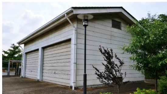
北西方面からの農耕車庫
