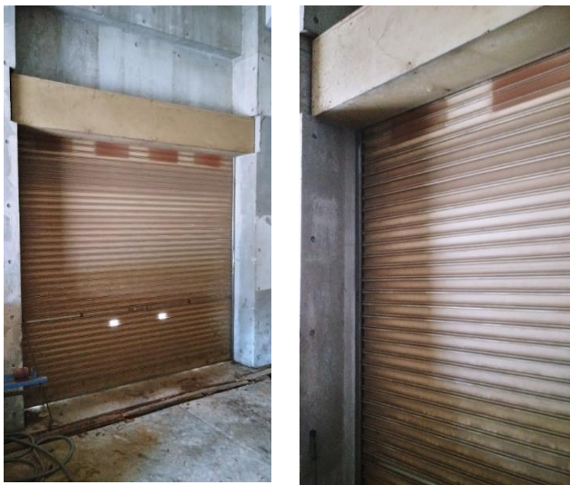
●軽量シャッター内側
