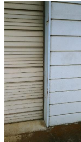
●三方枠納まり (外塗装除去)
