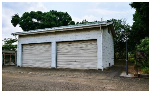
北面 オーバースライドシャッター2面
