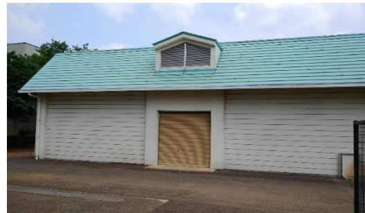
南面 軽量シャッター
