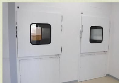
外部から持ち込む物品はパスボックスで紫外線殺菌します
