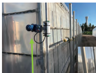
側窓開閉機構部
