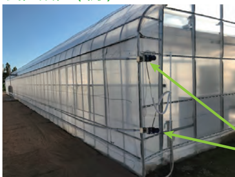
側窓開閉機構部の左側へ各2箇所設置例
