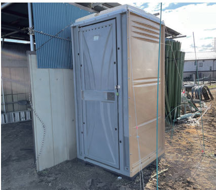
トイレの設置
