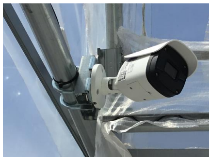
U字ボルトにてパイプに固定
