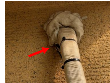
エアコンのダクト穴を利用
