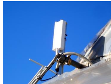
ハウス側窓巻き上げガイドポールへの設置
