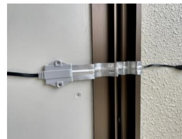
サッシに挟み込むケーブルを利用
