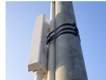
支柱への設置
