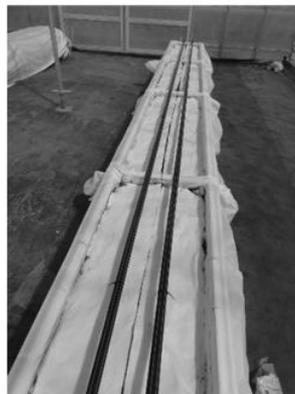
図3 点滴チューブを浮かせた設置状況(左: 模式図, 右: 実際の設置の様子)
