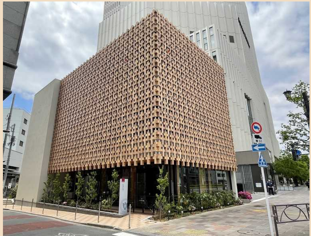
上智大学15号館(千代田区) 令和4年 4月竣工
