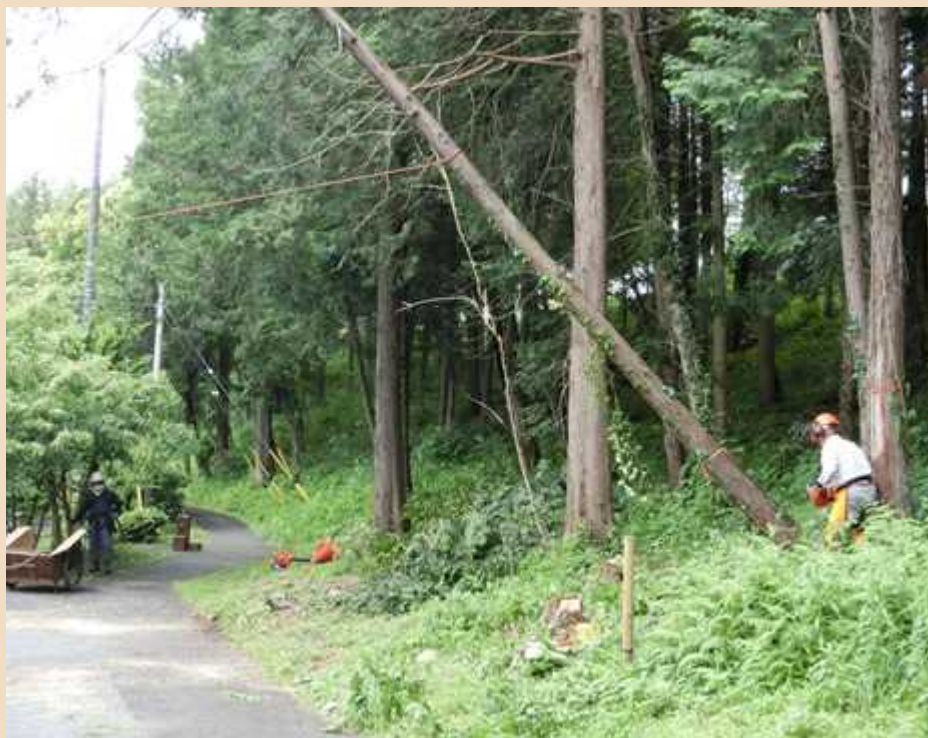
支障木の伐採 (羽村市美原里山緑地)
