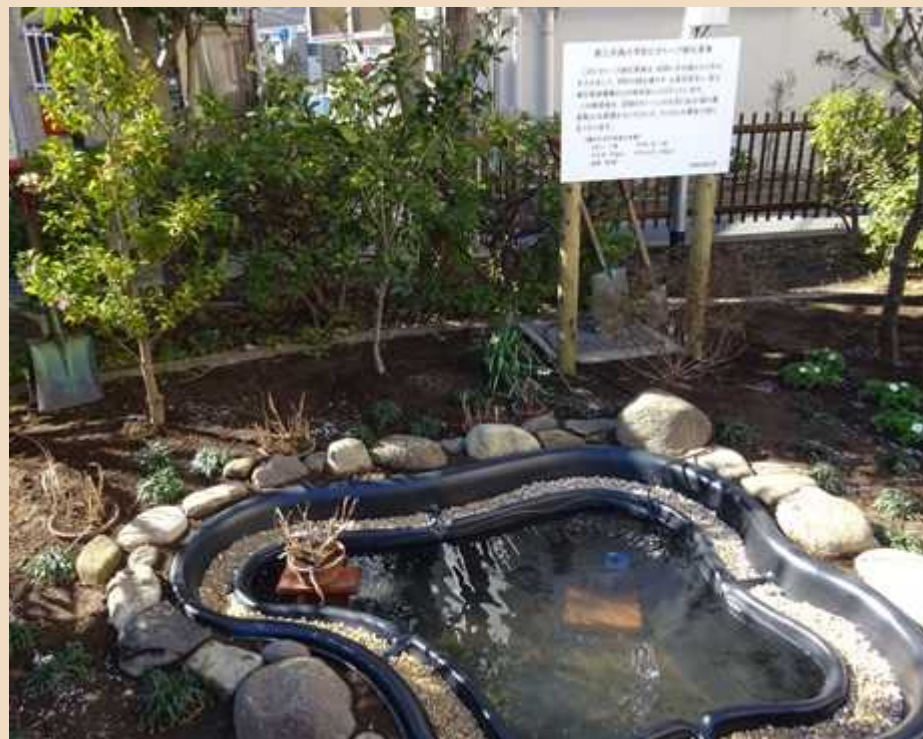
ビオトープ池整備工事 (墨田区立第三寺島小学校)
