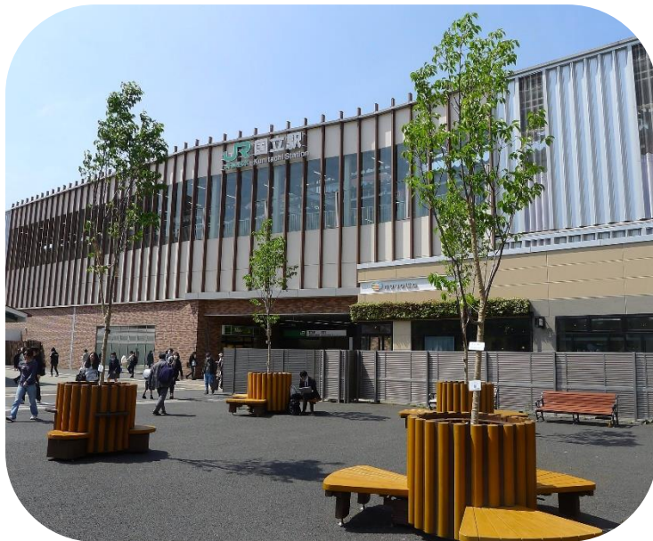
図1 動かせる緑陰ベンチの設置状況 (2023年5月10日撮影)
