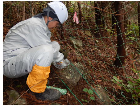
シカ柵補修作業
