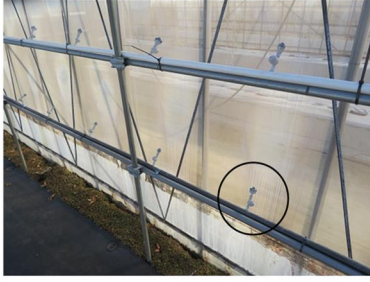
図1 ノズルを2段にしたネット&ファン 注) ○で囲んだものがノズルを示す。
