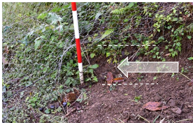
図 3 線径0.7mmの亀甲金網におけるイノシシによると推定される地際部からの侵入跡
