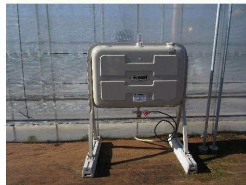
写真7 灯油タンク㉓198リットル
