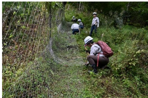
図3 幅1400mmの亀甲金網の追加設置状況
