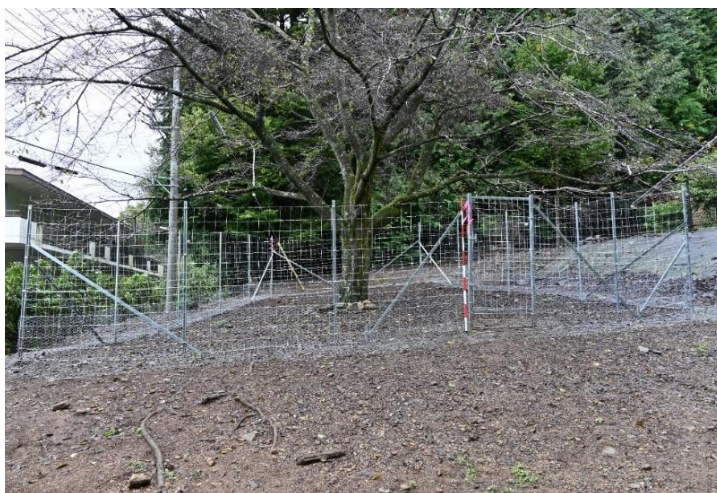
図 2 急斜面版シカ柵ライトの設置状況
