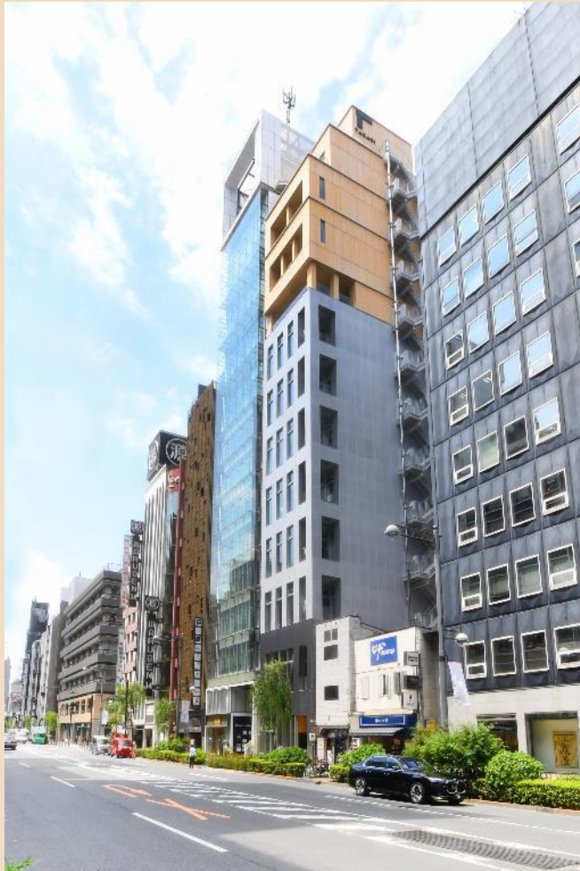
銀座 高木ビル(中央区) 令和5年5月竣工
