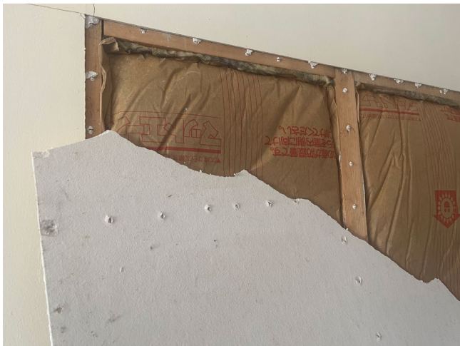
倉庫東側の部屋 南側壁材
