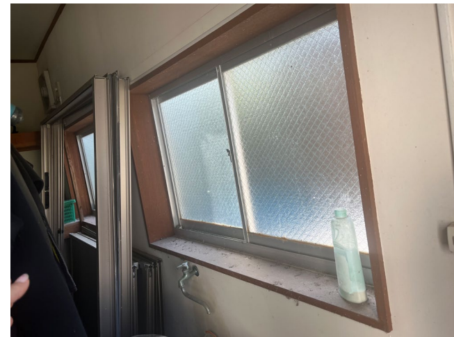
倉庫東側の部屋 北側
