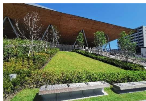
オリンピック・パラリンピック 跡地施設の緑化（有明 GYM-EX）
