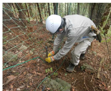
シカ柵補修作業
