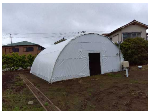
地上設置タイプの軟化施設
