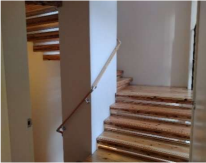
CLT階段： 多摩産材スギ (奥多摩演習林産材)
