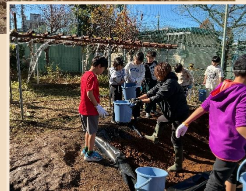
ビオトープ池整備工事 (世田谷区立玉堤小学校)
