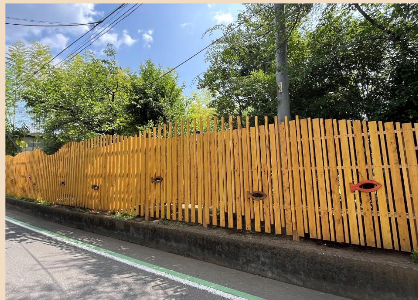
きよせ幼稚園(清瀬市) 令和7年9月竣工
