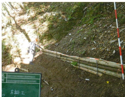
現地発生材を使用した木柵工
