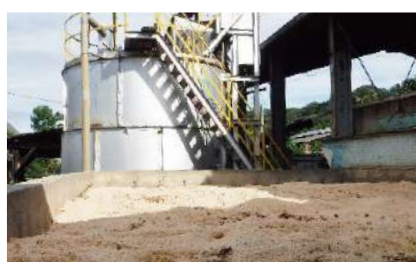
脱臭槽(手前)と堆肥化装置(奥)
