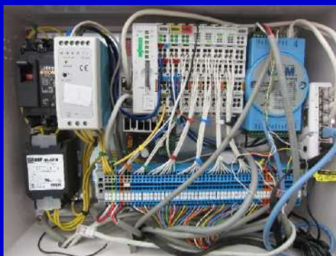
作物の最適な環境をつくる コンピューター制御
