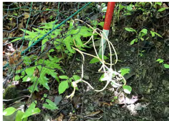
シカ柵補修作業 (H29. 5. 10)
