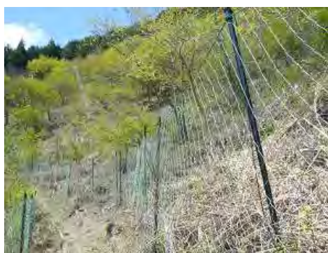
シカ柵の設置状況
