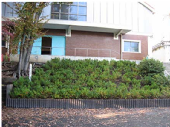
社会公共施設緑化 (武蔵野市立第二小学校)
