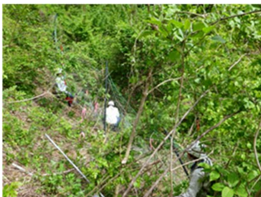
シカ柵補修作業 (H26. 5. 12)
