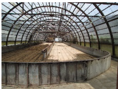
横型ロータリー式発酵槽
