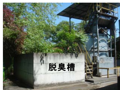
図9 脱臭槽設置状況
