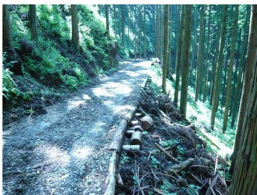
図 8 急傾斜地に作設された作業道
