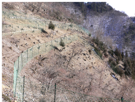
シカ柵設置状況
