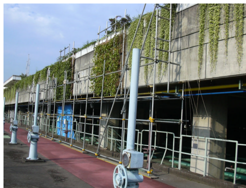
苗木供給事例（壁面緑化：新河岸水再生センター）
