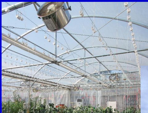
明るい室内の栽培ハウス 保温効果の高い二重張りビニール
