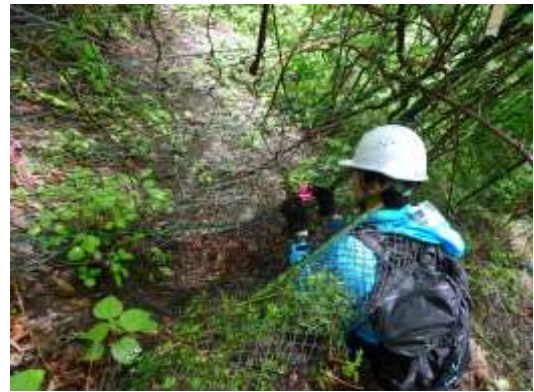
シカ柵補修作業
