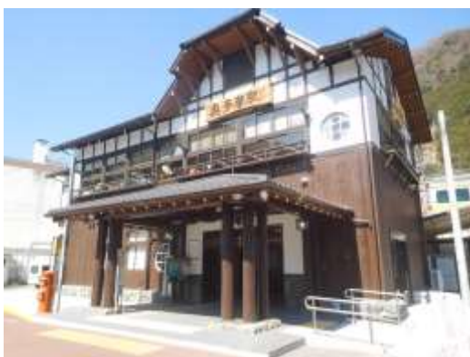
JR 奥多摩駅舎改修
