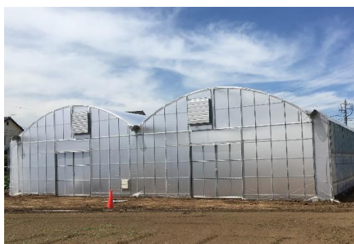
あきる野市の現地実証施設
