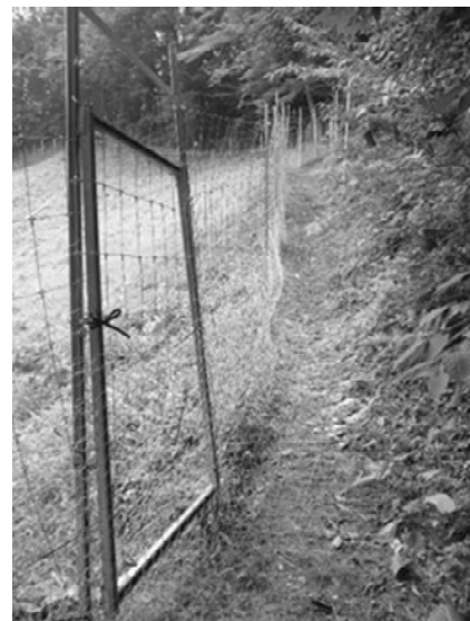
図4 急斜面版シカ侵入防止柵による対策
