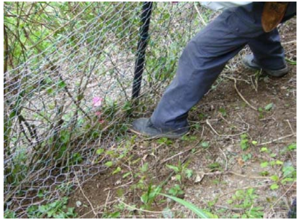
図2 地際部の折り曲げ状況 足で地際部を踏み込んで、設置していく。
