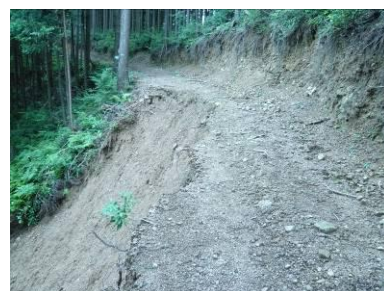
図6 路側崩落
