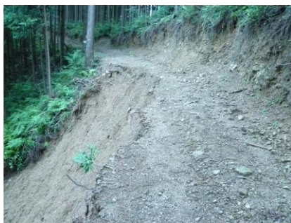
図1 路側崩落
