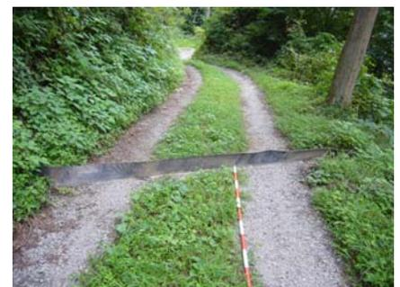
図4 横断排水溝（ゴム製）
