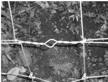
図3 上段の網と下段の網との接合状態短めのシノーを用いて結合した。
