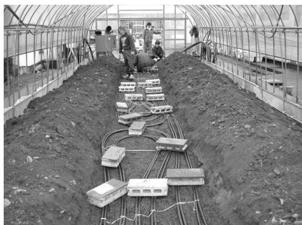
図2 地下蓄熱用の埋設ポリエチレンパイプ
