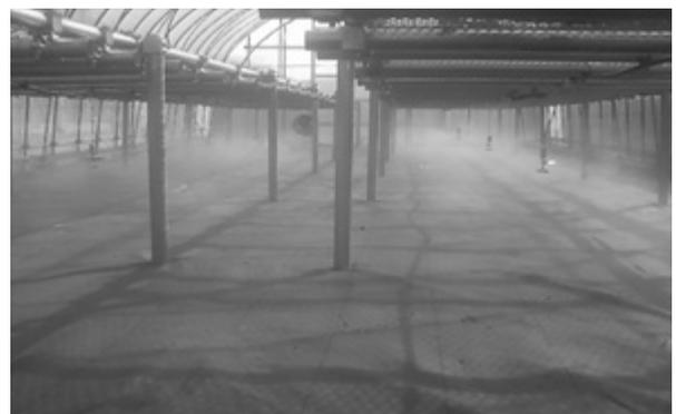
図6 ベンチ下のミスト装置による冷房
