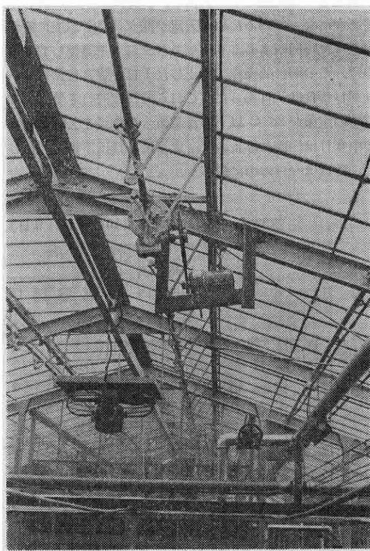
第36図 天窓自動開閉装置と強制換気扇
