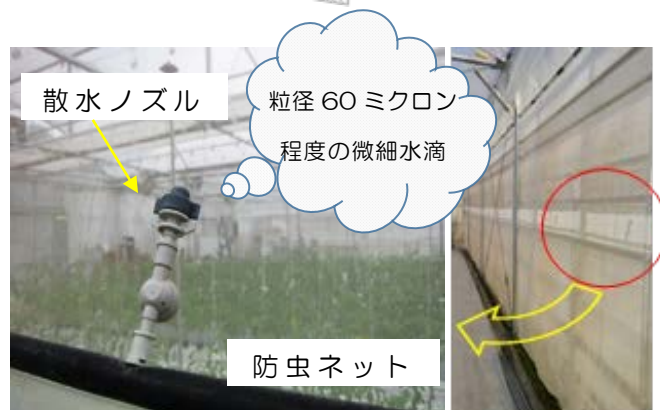
図2 細霧ノズル設置状況と模式図
