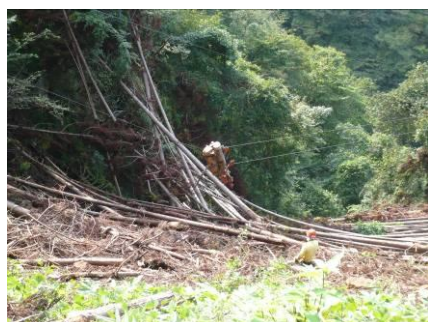
図1 作業状況（山中）
