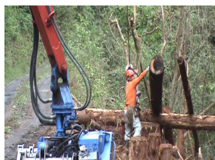
図3 ロープの取り外し作業
