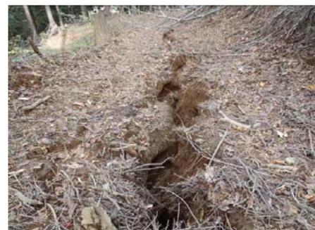
図3 路面洗掘の発生状況
