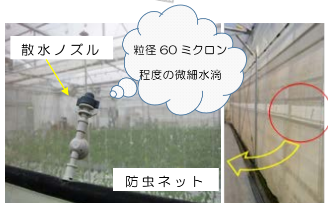
図2 細霧ノズル設置状況と模式図
