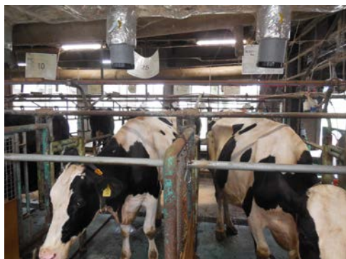
図 3 スポット冷房による送風
