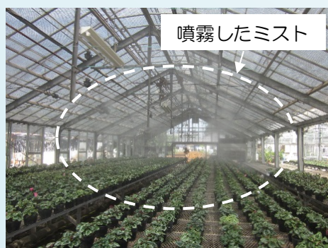
図 1 ミスト冷房装置を備えたハウス
