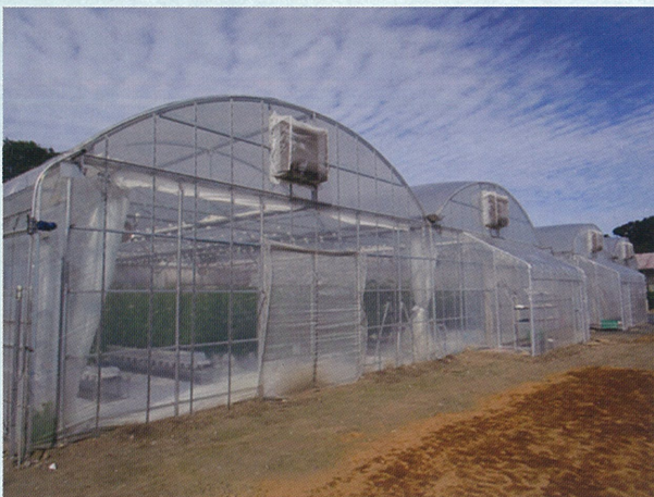
図1 東京型統合環境制御生産システム外観
