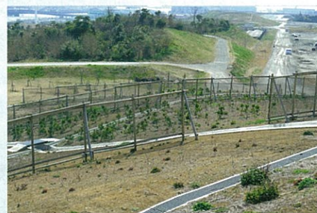
図2 植栽と同時に防風対策を実施
