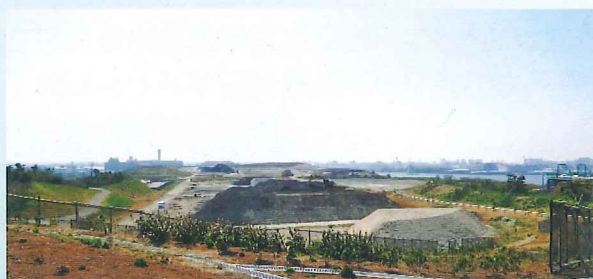
写真1 「海の森」建設地
